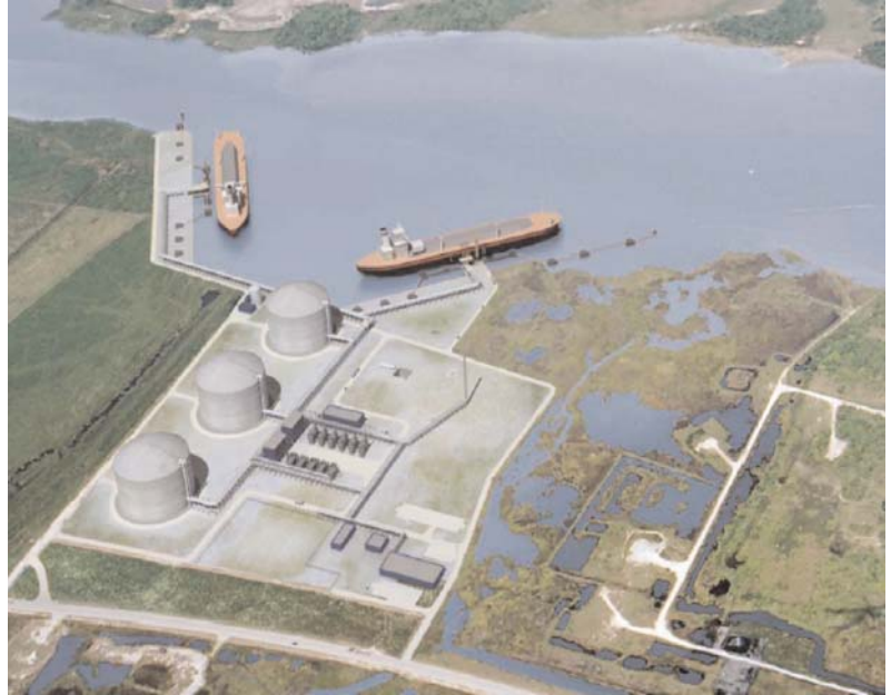
Proposed Cameron LNG Terminal.
